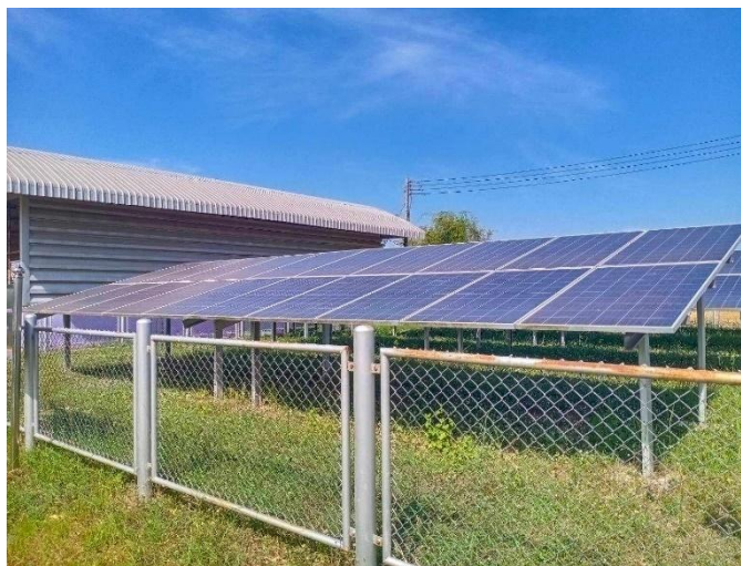
รูปที่ 3 ชุดผลิตกระแสไฟฟ้าด้วยโซลาร์เซลล์ขนาดกำลังผลิต 20 กิโลวัตต์
