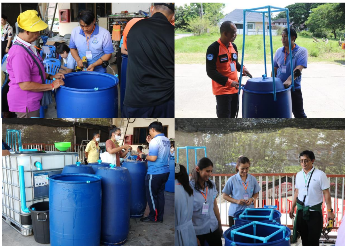
ภาพที่ 6 การเตรียมถังเก็บก๊าซชีวภาพขนาด 150 ลิตร
