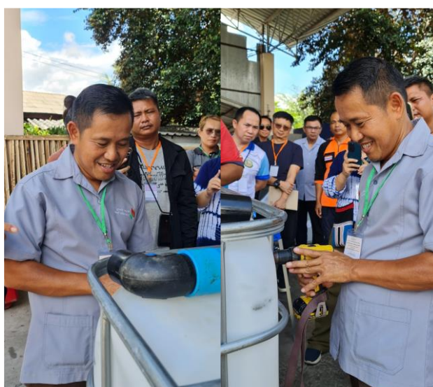
ภาพที่ 2 การเจาะช่องสำหรับท่อน้ำล้น
